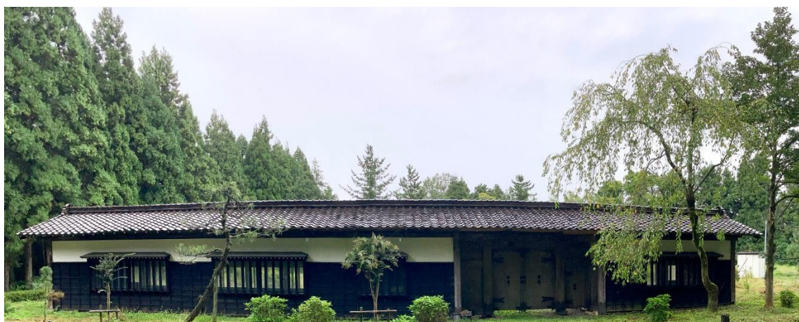
屋根修繕を終えた長屋門外観(南・市道側より)
