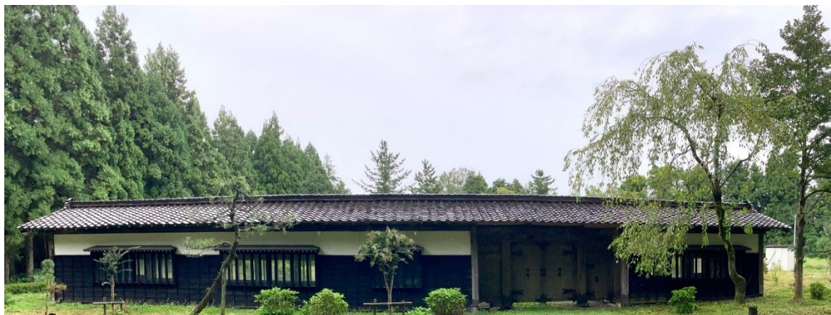
屋根修繕を終えた長屋門外観（南・市道側より）
